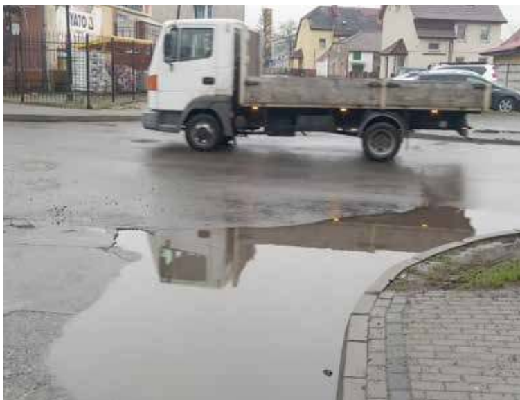
Widocznej na zdjęciu ogromnej kałuży by nie było, gdyby nie zapchana studzienka kanalizacyjna
