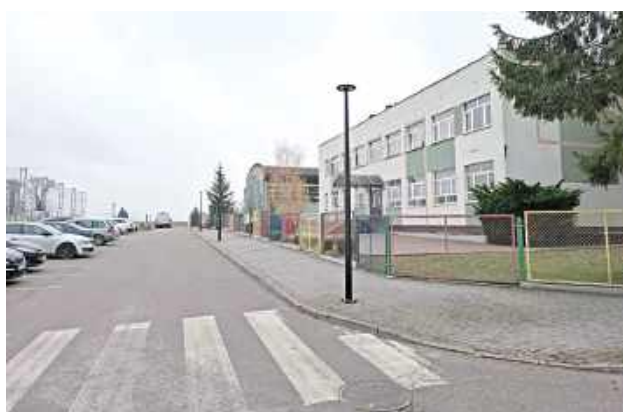
Prace zostały wykonane przez Zakład Gospodarki Komunalnej w Żelechowie
