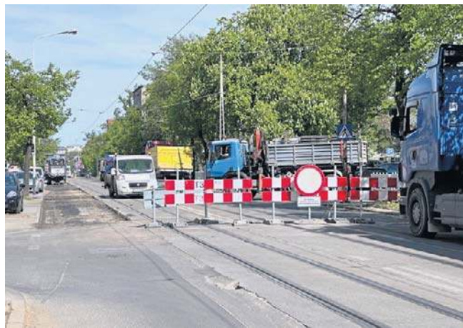
Tak wyglądała Rzgowska w pierwszym dniu remontu. Prace mają tam potrwać aż dwa lata
