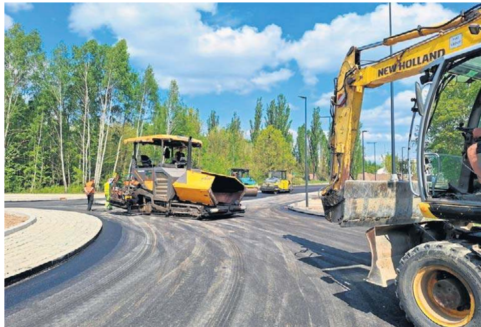
Wczoraj zaczęło się układanie asfaltu na nowo wybudowanym przedłużeniu ulicy Kaczeńcовой
