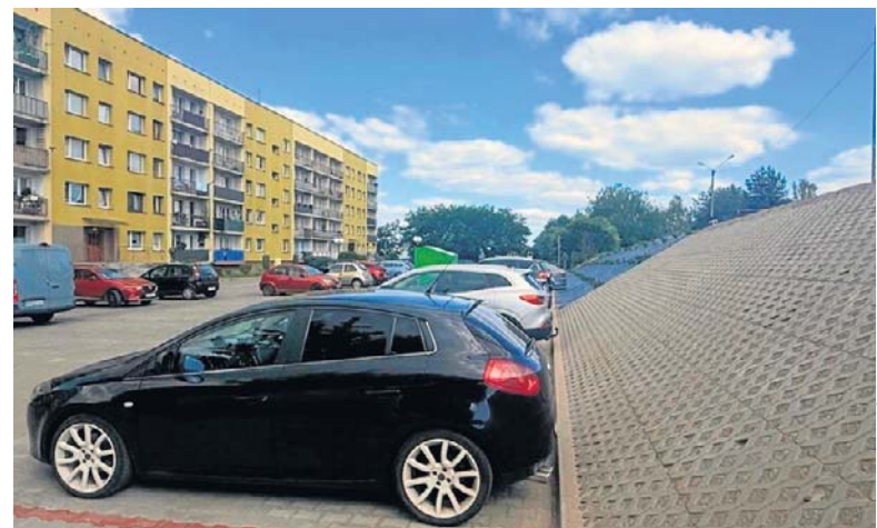
Parking przy ul. Urzędniczej w Libiążu gotowy. Teren został uporządkowany, powstało 17 nowych miejsc postojowych
