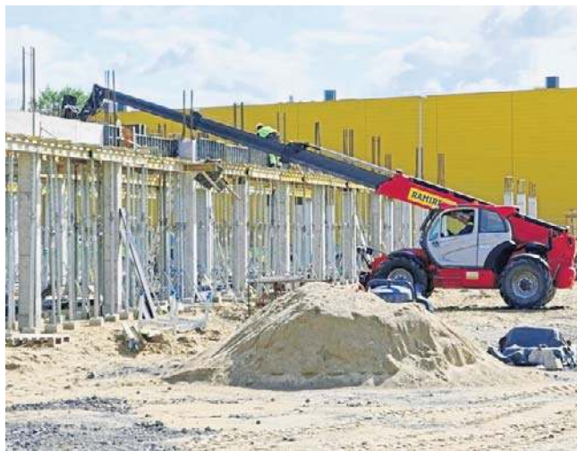
Przy ulicy Lipowej budowane jest centrum Lipowa Vita. Powstaje na tyłach sklepu „Agata”
