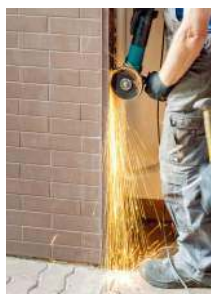
❷ Demontaż. Zdjęcie skrzydła i odcięcie wszystkich elementów ościeżnicy.
