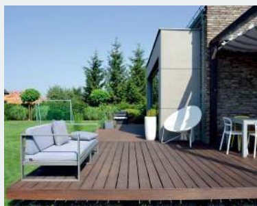
Podest z drewna bangkirai oparto na betonowym punktowym fundamencie.
