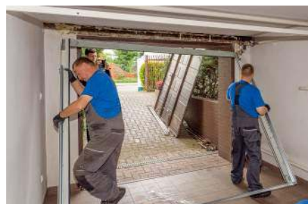
❸ Montaż nowej ościeżnicy do poprzedniej, przymocowanej do ściany nośnej budynku.
