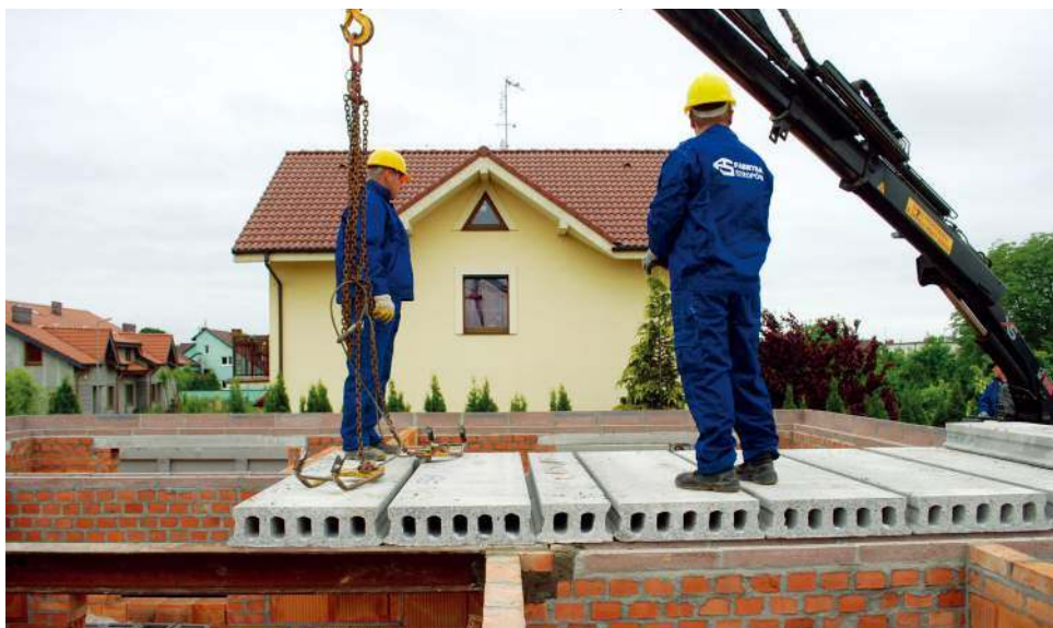
🔧 Prefabrykowany strop panelowy można ułożyć w dwie godziny, bez konieczności korzystania z ciężkiego dźwigu, wystarczy samochód z dźwigiem typu HDS. STROPY.PL
