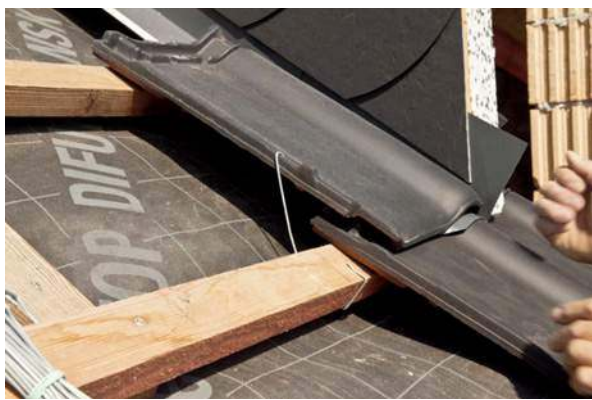
📌 Dachówki mocuje się zazwyczaj na spinki dekarские. Informację o liczbie elementów, które powinny być przytwierdzone mechanicznie, znajdziemy w projekcie domu i w materiałach producenta pokrycia. RÖBEN
