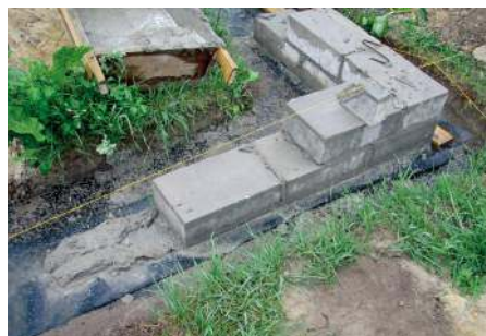
Murowanie ścian fundamentowych.
