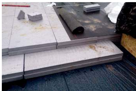
Hydroizolacja i termoizolacja pod płytą fundamentową.
