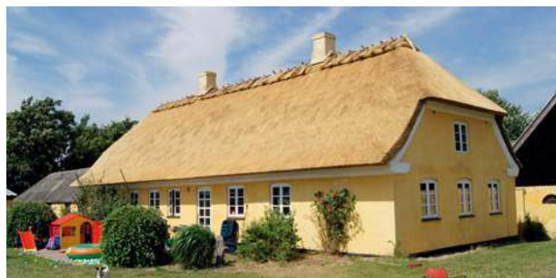
Strzecha jest jednym z najcięższych pokryć, dlatego wymaga mocnej więźby. DACH-REED
