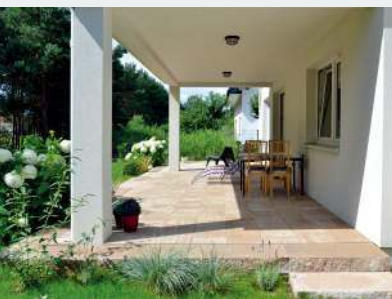
➤ Taras na gruncie otoczono gotowymi elementami z fakturą łupanego piaskowca (na jednym boku).
