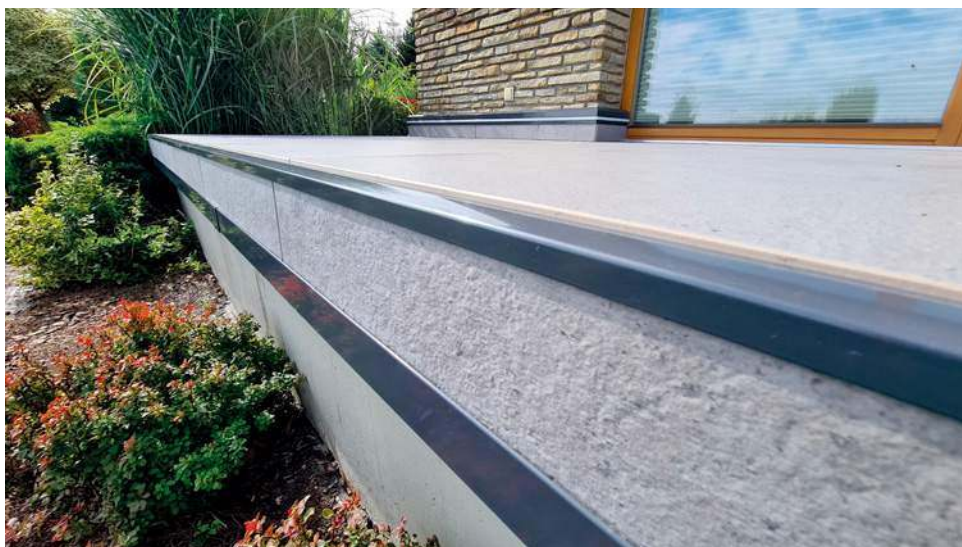
📌 Krawędź tarasu pokrytego płytkami wykończona estetycznymi profilami. RENOPLAST
