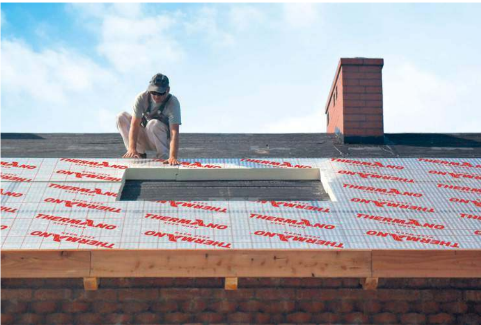
🔧 Ocieplanie dachu płytami PIR metodą nakrokwiową. BALEX METAL
