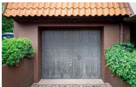
❶ Stara brama uchylna z wypełnieniem z drewnianych paneli.
