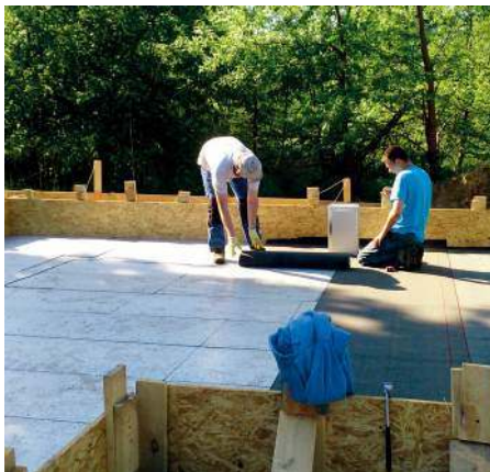
Układanie hydroizolacji na ociepleniu płyty fundamentowej.
