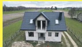
Dom w stanie surowym otwartym, Wólka Siemieńska, 885 851 160
