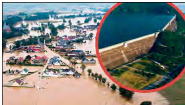
Lokalnym władzom udało się przekonać rząd w sprawie budowy zbiornika przeciwpowodziowego na Osobłódzie.
