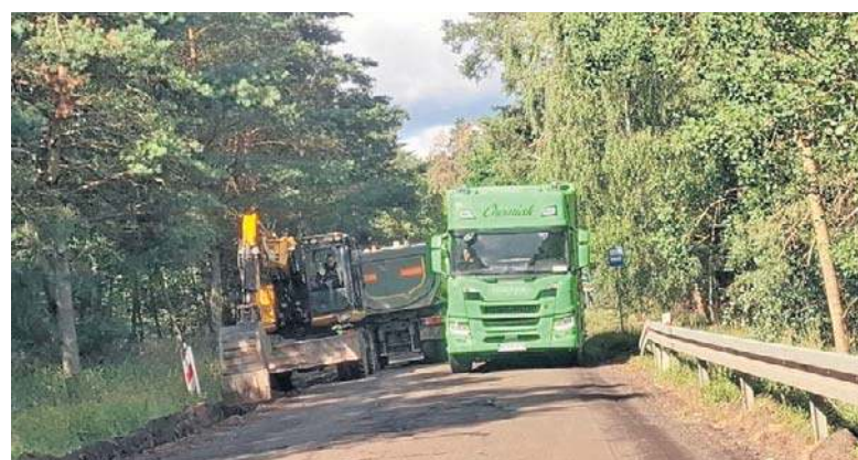
Przebudowywany jest 3-kilometrowy odcinek drogi pomiędzy Olszówką i Okoninem
