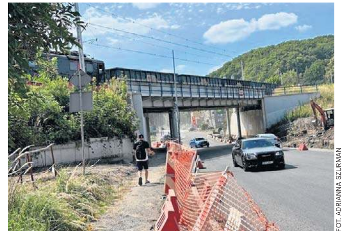
Na remontowanej ulicy prace drogowe nadal trwają, a utrudnienia dla kierowców są spore
