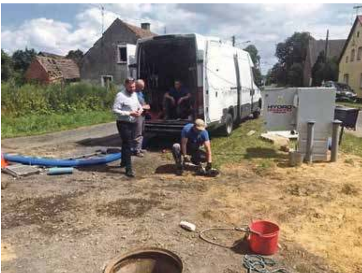
Jest to jedna z czterech stacji w tej miejscowości przewidziana do przebudowy
