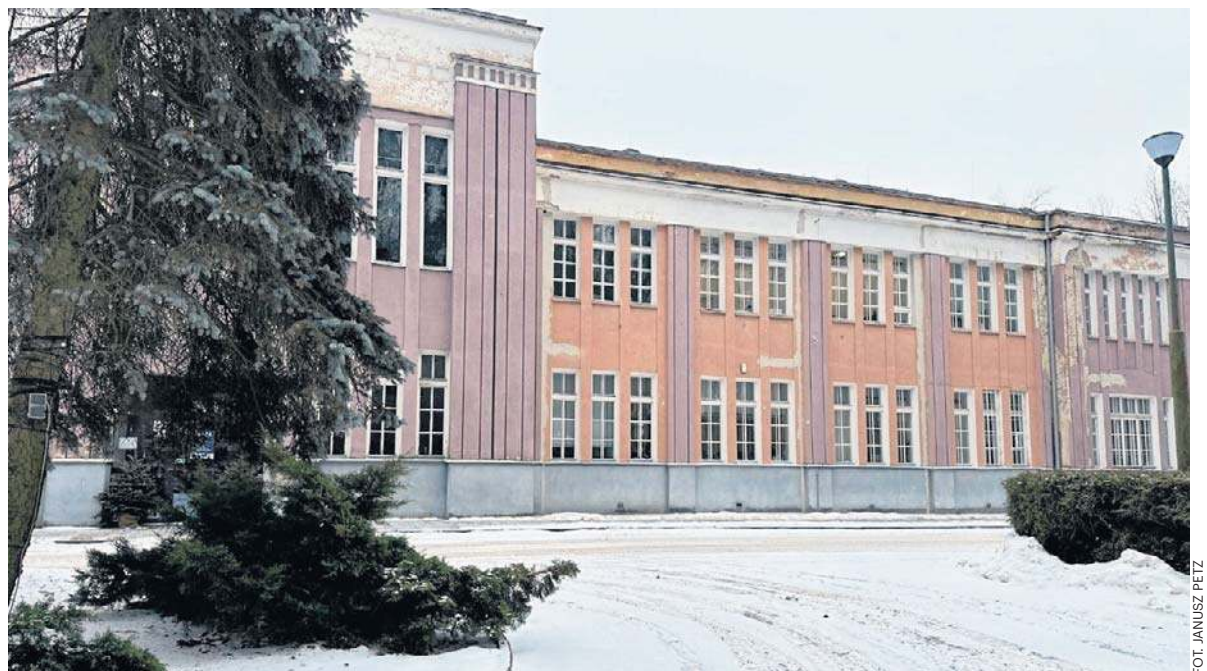
O latach świetności pionkowskiej zbrojeniówki przypomina budynek administracyjny dawnego Pronitu
