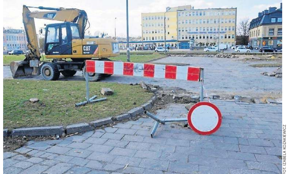
Parking w Radomiu jest zamknięty od kilku dni, na razie tempo prac przy jego przebudowie nie powala. Pracuje jedna koparka, jest kilka zdjętych płyt
