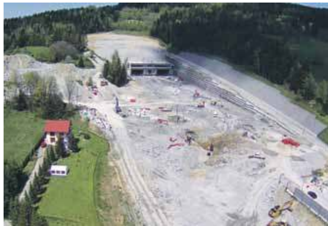
Czy pojedziemy już w czerwcu nowym tunelem?
