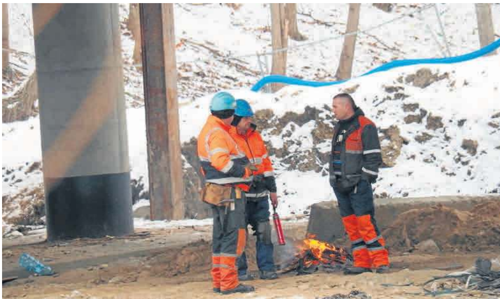
Na budowie wczoraj spotkać można było tylko kilku robotników
