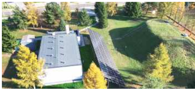
W ramach prac zmodernizowano ujęcia wody oraz stację uzdatniania wody
