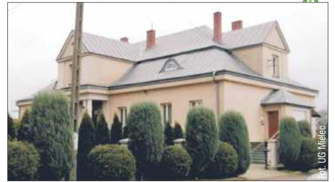
Prace remontowe przy plebanii w Książnicach dobiegły końca.
