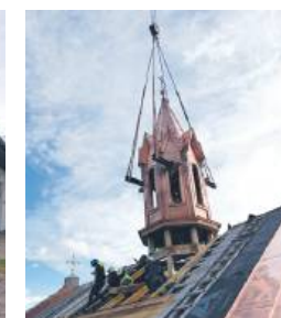
Remont wieżyczki kościoła
