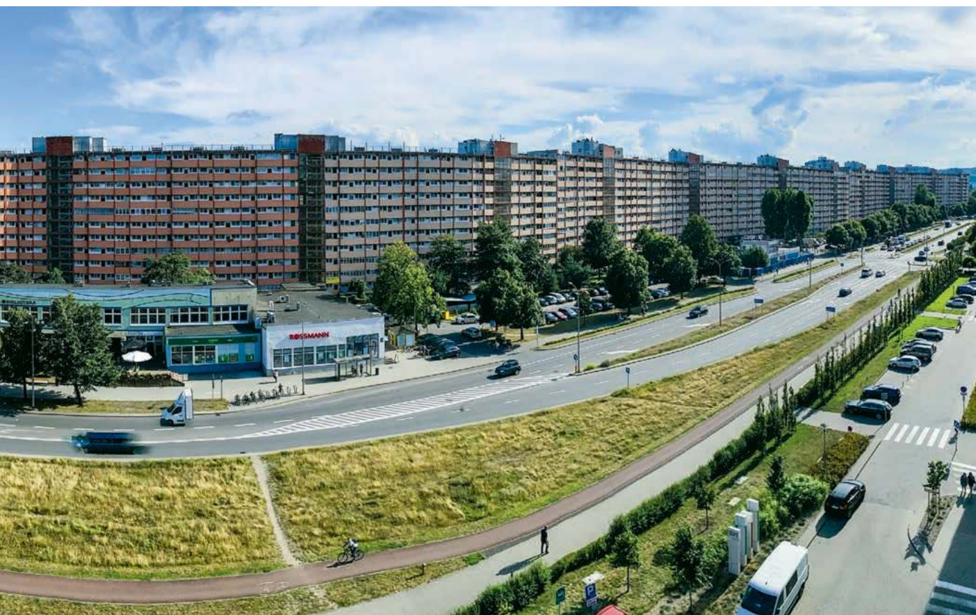
Falowiec przy Obrońców Wybrzeża w Gdańsku, widok z nowego bloku po przeciwnej stronie ulicy. Lipiec 2020 r.
