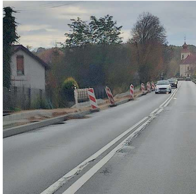
Budowany chodnik od ul. Krakowskiej w Alwerni do granicy z Porębą Żegoty
