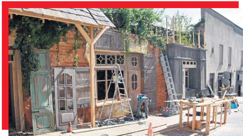
Tarnów. Na Wielkich Schodach i Tarasie trwa montaż scenografii do zdjęć nowej produkcji Netflixu. Pozostałości spalonej kilkanaście lat temu kamienicy zyskują nową zabudowę.
