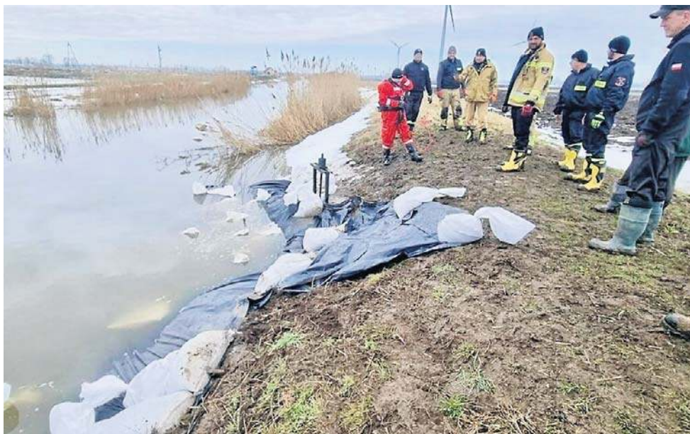
Niedawno strażacy z powiatu malborskiego pracowali na wale rzeki Świętej osłabionym przez norę bobrów
