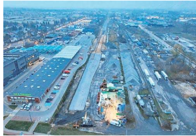
Trwa budowa stacji kolejowej w Łomży
