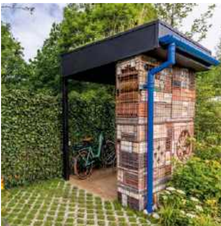
Wiata ze ścianą wykonaną z materiałów z odzysku jest miejscem dla rowerów i domem dla owadów
