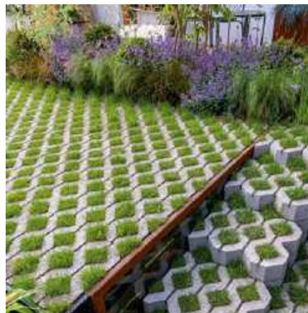
Podniesione rabaty, podjazd i schody wykonane są z ażurowych płyt betonowych, a ich otwory wypełnione trawą
