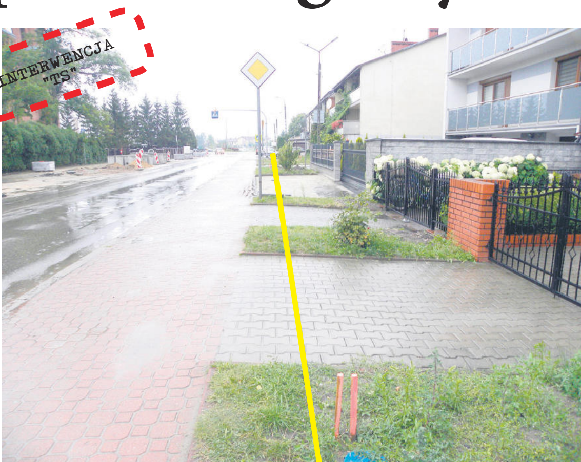
Po lewej stronie tej orientacyjnej linii ma powstać asfaltowa ścieżka rowerowa, a po prawej chodnik.
