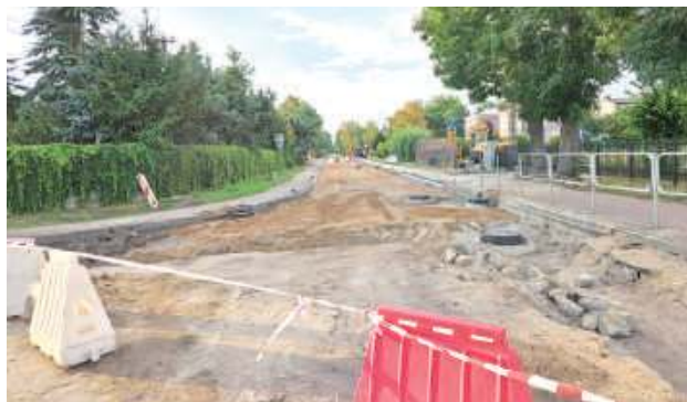
Trwają prace przy Urzędzie Gminy oraz przy Szkole Podstawowej
