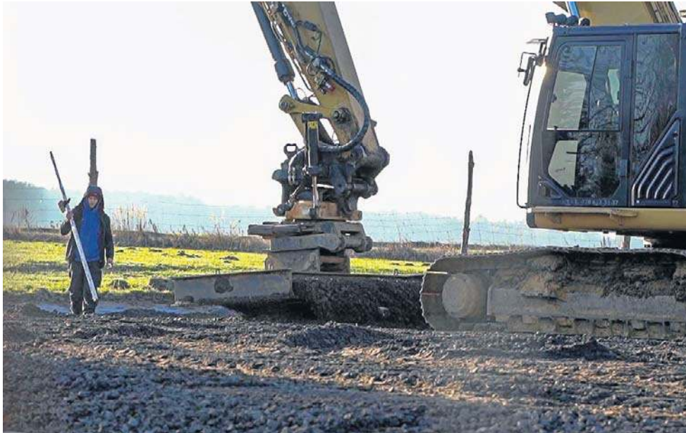
Pracownicy wykonawcy z wykorzystaniem ciężkiego sprzętu pracują już przy placówce
