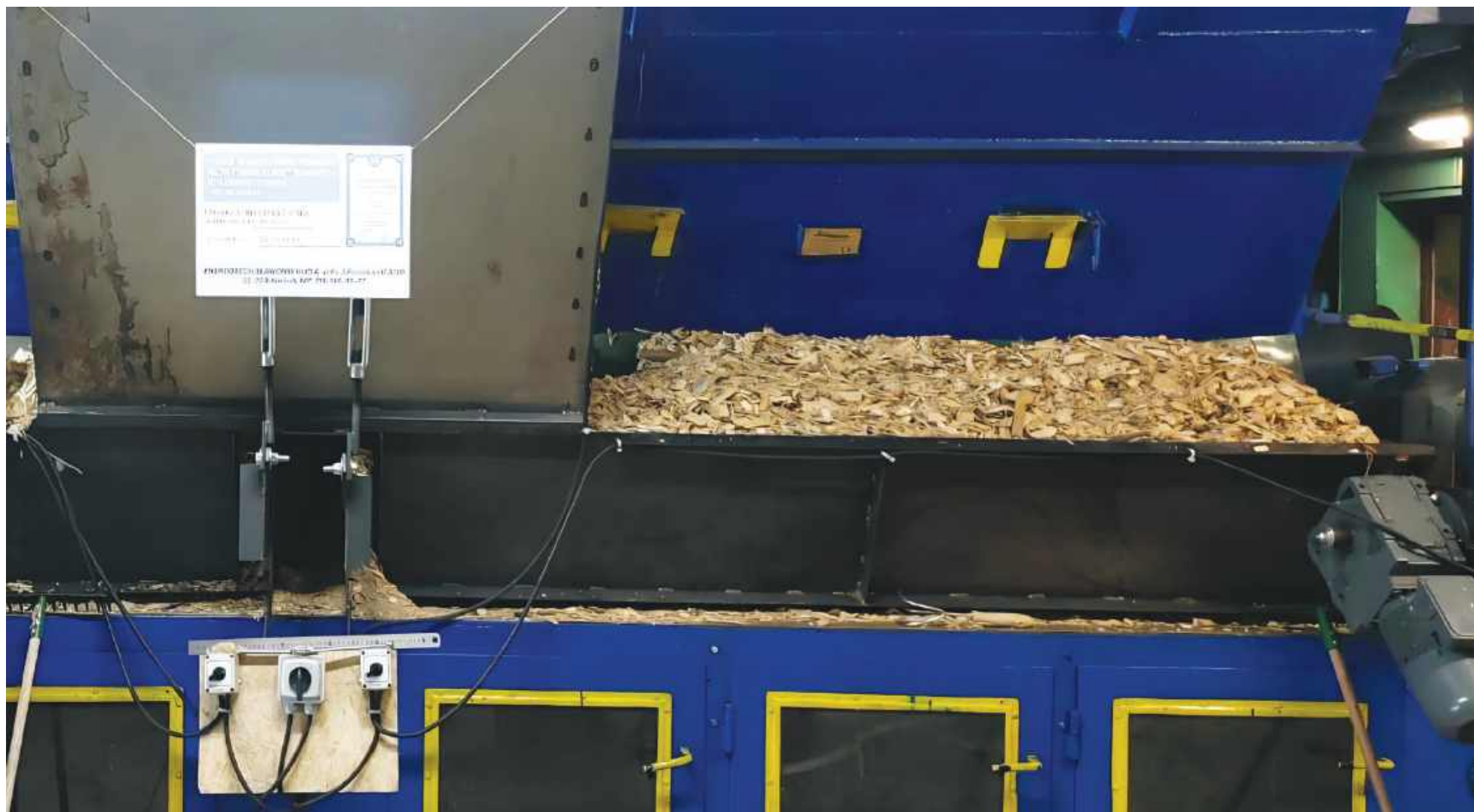
W maju 2026 roku, we współpracy z ekspertami oraz pod nadzorem Urzędu Dozoru Technicznego, przeprowadzono próby techniczne współspalania oraz spalania biomasy w kotle WR-25. Ich celem było zebranie doświadczeń eksploatacyjnych oraz przygotowanie do właściwego programu badań, który planowany jest na sezon grzewczy 2026/2027.
