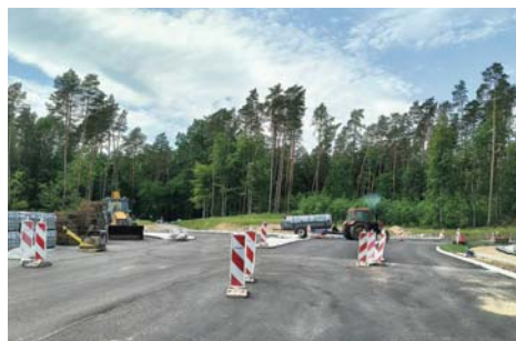
Asfalt już jest. Co dalej? |4
