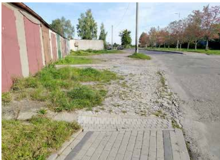
To już koniec istniejącego odcinka chodnika, który dalej mógłby prowadzić w stronę ogrodów działkowych
