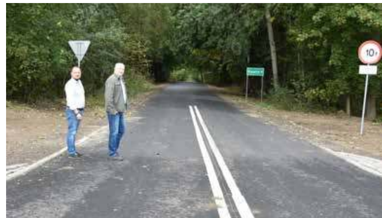
Wizytacja na miejscu inwestycji w Osinie na odcinku, który został już częściowo wykonany
