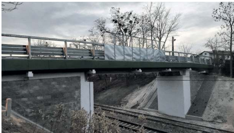
Wiadukt na Traugutta czeka na odbiór techniczny
