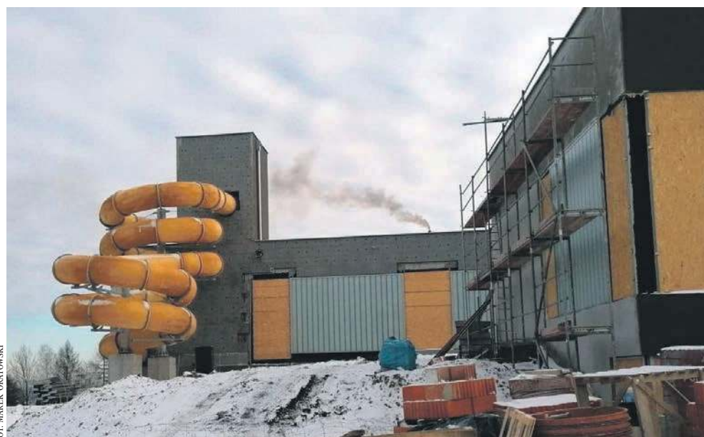
Na zewnątrz widać już zjeżdżalnię. Video z budowy jest dostępne na www.przelom.pl
