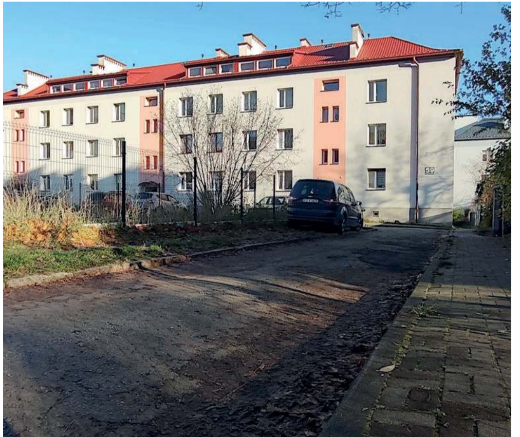
Droga dojazdu do bloku przy Alei Henryka 59 w Chrzanowie
