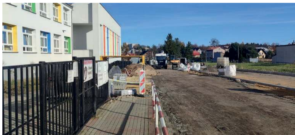
Modernizacja Dworskiej w chrzanowskim Kościelcu
