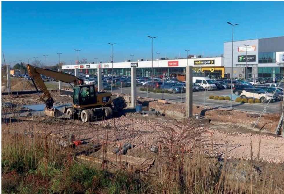
Trwa budowa nowego obiektu przy Kasztelanii
