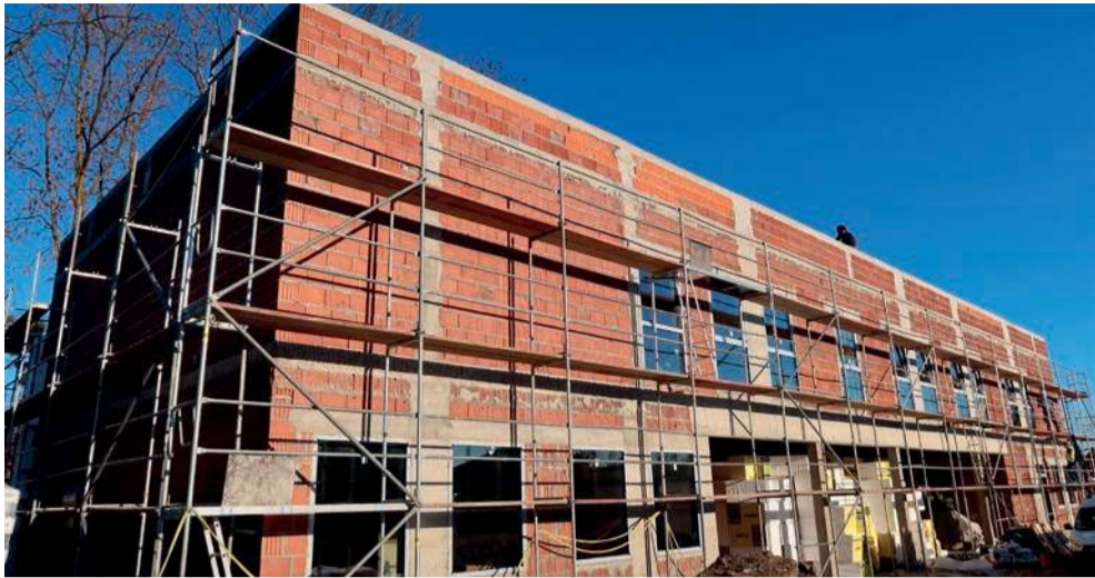
Budynek techniczno-administracyjny jest już w stanie surowym zamkniętym
