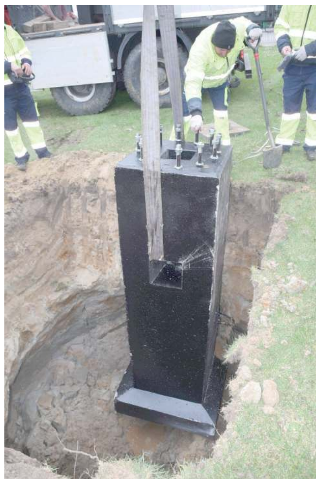
Fundamenty zostały już zakopane. Będą dźwigać 18-metrowe słupy z jupiterami
