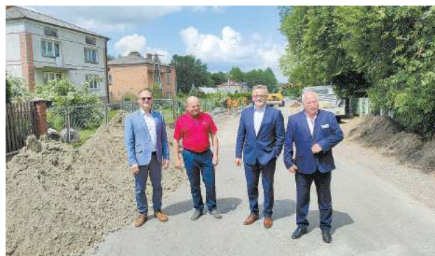
Budowa drogi powiatowej w Rudzie-Hucie
