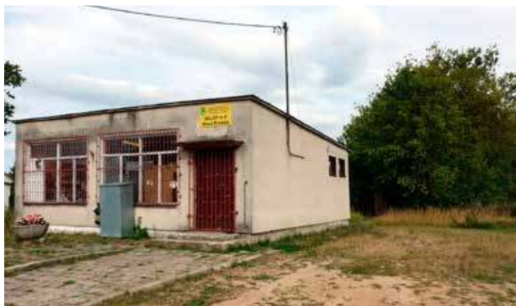
Tu za rok będzie nowa świetlica wiejska
