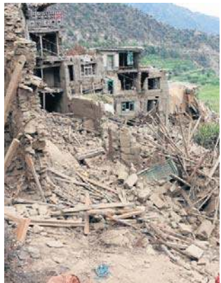
Zniszczeniu uległy m.in. zabytki. Ratownicy walczyli przez całą noc
