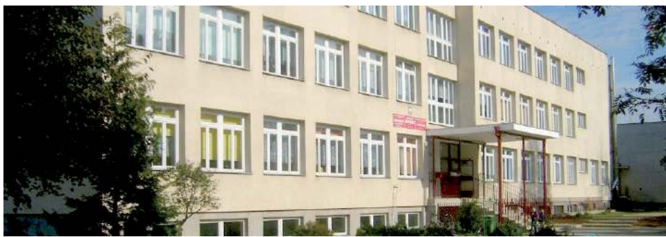
Jeszcze w tym roku Zespół Szkolno-Przedszkolny w Baranowie przejdzie głęboką termomodernizację
