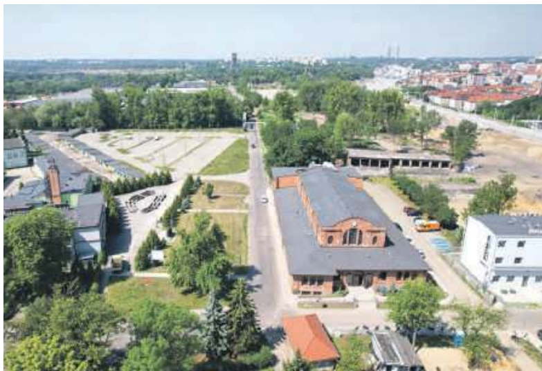
Na remont ulicy Kilara bytomianie czekają od dawna
