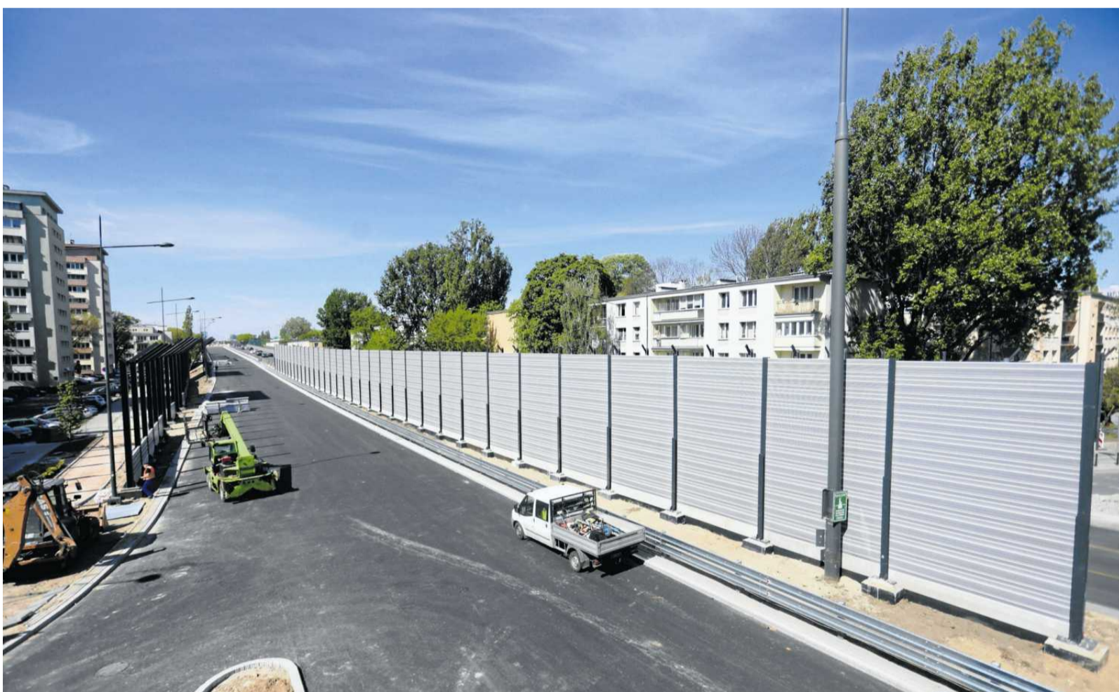
• Pośrodku Al. Stanów Zjednoczonych stanęła ściana szarych ekranów akustycznych. FOT. JACEK MARCZEWSKI / AGENCJA WYBORCZA.PL
