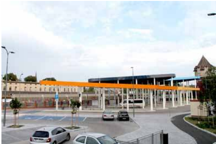
Jednym z projektów zrealizowanych przy wsparciu środków unijnych była budowa Zintegrowanego Centrum Przesiadkowego
