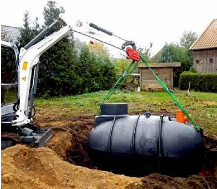
Gmina Dobrzany zabezpieczyła w budżecie 30 tys. zł na dofinansowanie budowy przydomowych oczyszczalni ścieków
