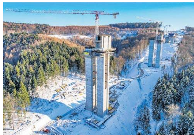
Na najwyższej estakadzie prowadzone są roboty zbrojarskie, deskowania i betonowania podpór
