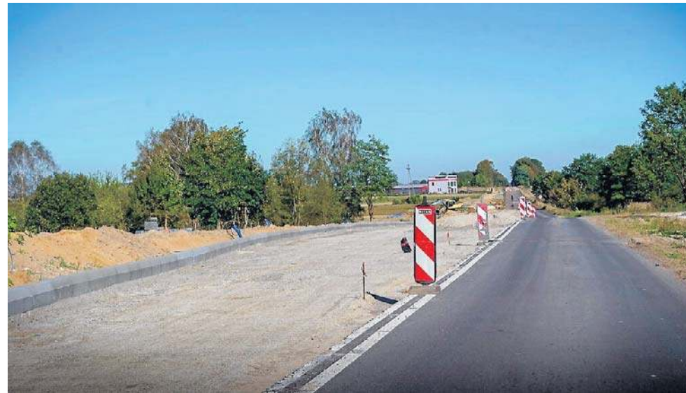
Odcinek Działoszyn - Szczyty to kolejny fragment drogi wojewódzkiej nr 486, który jest modernizowany
