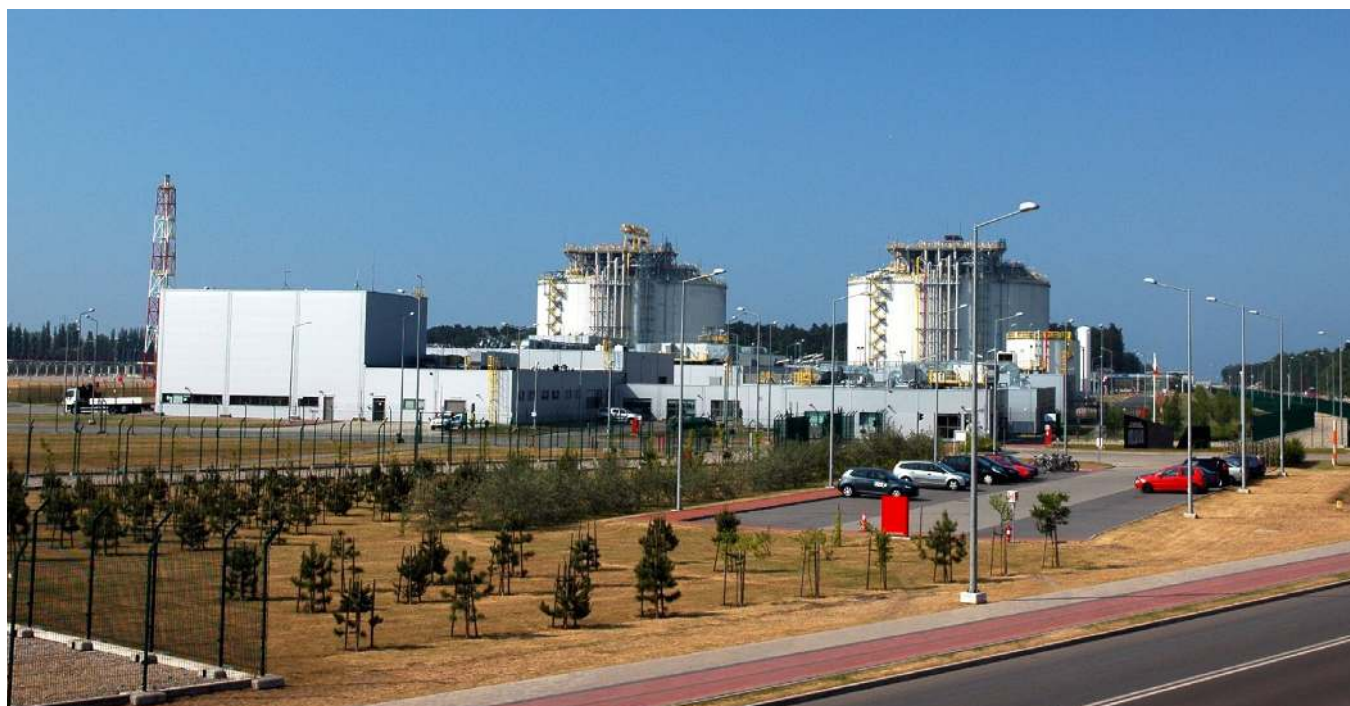
Fot. 3. Infrastruktura gazoportu w Świnoujściu
