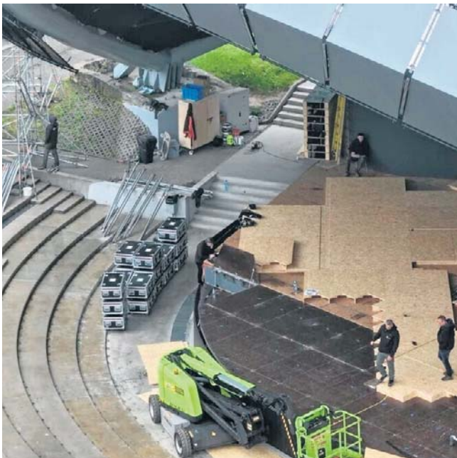
W amfiteatrze opolskim trwają już intensywne prace związane z montażem sceny festiwalowej.
