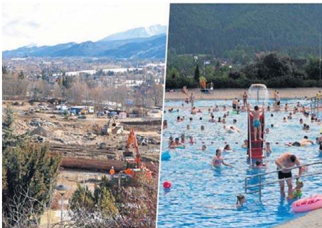
Kąpielisko na Polanie Szymoszkowej zrównane z ziemią. Powstaje nowy kompleks basenów termalnych
