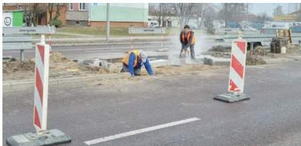
Przejście dla pieszych umożliwi mieszkańcom osiedla Sienkiewicza szybkie przedostanie się do Vendo Parku
