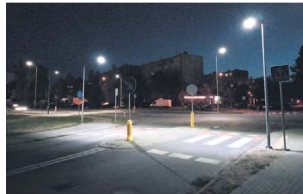
Doświetlone przejście przy al. LOP/ul. Warszawskiej.
