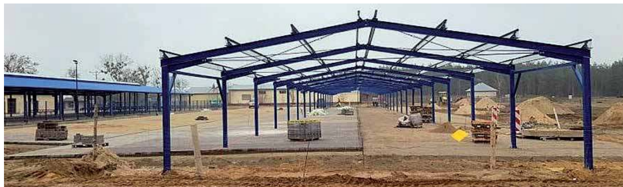
Prace na chorzelskim targowisku mają potrwać do końca czerwca 2020 roku
