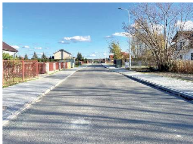
Ulica Piłsudskiego w Biłgoraju już po remoncie
